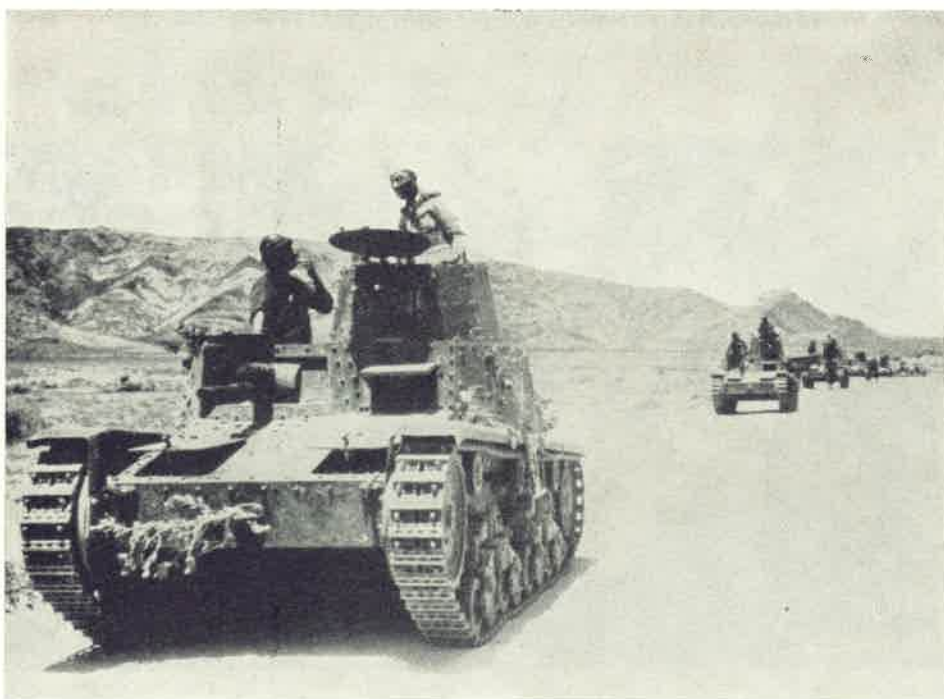
Carro M. 11/39: costruito nel 1939, pesava 11 tonn. Era armato di un cannone da 37/40 e 2 mitragliatrici. Velocità 32 km/h; corazzatura: 30/6 mm.; equipaggio: 3 uomini. Aveva l'inconveniente del cannone in casamatta e risenti dell'affrettata messa a punto. Fu impiegato in Africa Settentrionale nel 1940 e in A.O.I. nel 1941 (nella foto).
