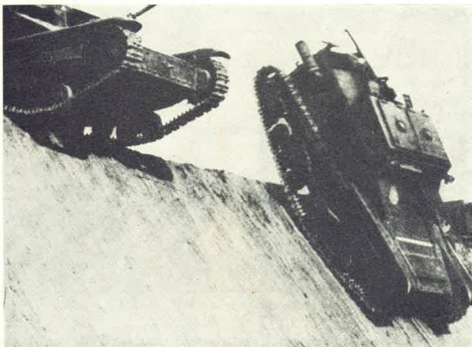
Il Carro L 3 (denominato anche carro veloce 33 e L 35), terzo carro armato costruito in Italia ed entrato in servizio nel 1933. Pesava 3,2 tonnellate. Era armato di due mitragliatrici da 8 mm. tipo Fiat 35 (l'ultima serie, di due Breda 38). Velocità: circa 42 km/h. Equipaggio: 2 uomini. Questo mezzo è il più caro al cuore dei vecchi carristi perché al nome del carro L 3 sono legate le battaglie dell'Africa Orientale, O.M.S., fronte occidentale, Jugoslavia, Albania, Grecia e Libia, in un primo tempo. Molto veloce e maneggevole, era poco protetto (14/7 mm.) e con armamento insufficiente ed in casamatta.
