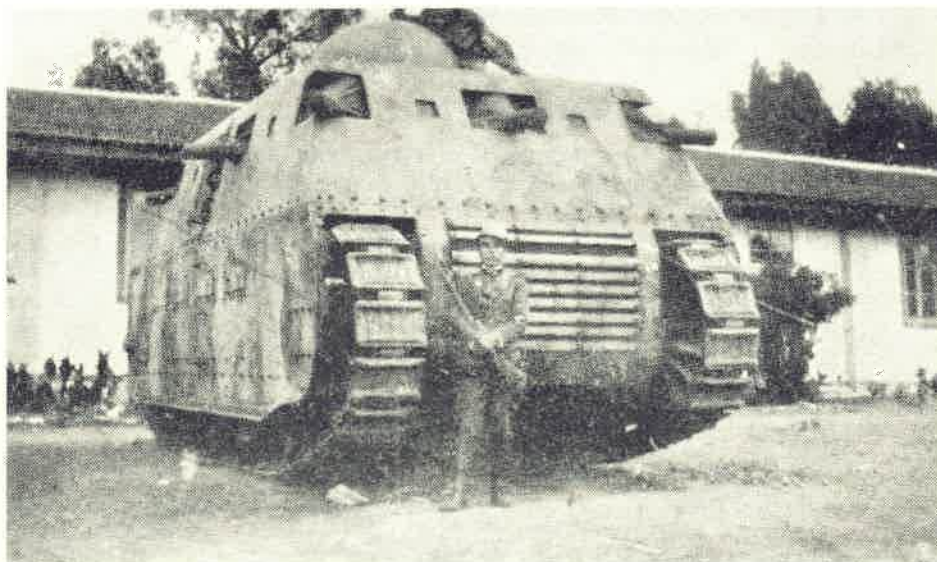
Carro italiano « Fiat 2000 » costruito nel 1918. Era armato di un cannone da 65 e di 7 mitragliatrici. Pesava 40 tonnellate, con un equipaggio di 10 uomini. Pur con la sagoma piuttosto ingombrante e la velocità ridotta (6 km.), questo mezzo, per il cannone sistemato in cupola girevole e per le mitragliatrici che coprivano un settore di 360°, può considerarsi il primo vero carro armato degno di questo nome.
