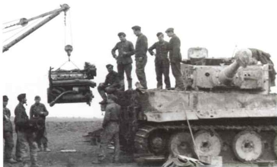
Si scavalca il propulsore Maybach dallo scafo di un Tigre I. Da notare il treno di rotolamento incrostato dal fango. Uno degli inconvenienti di un "Tigre I".
