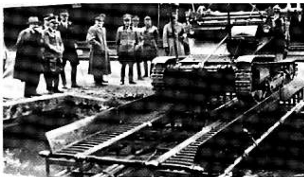
zo, collocata la passerella per il superamento di un canale, vi passa sopra per primo (seguiranno i carri del reparto).
