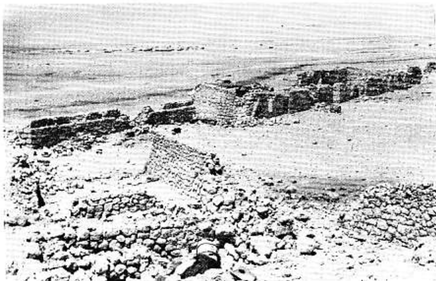
Un particolare della Ridotta Capuzzo.
