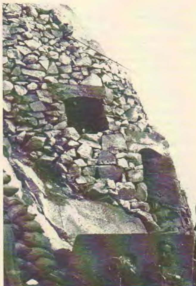
Il fortino all'esterno della galleria, di costruzione austriaca, in calcestruzzo e pietrame.
