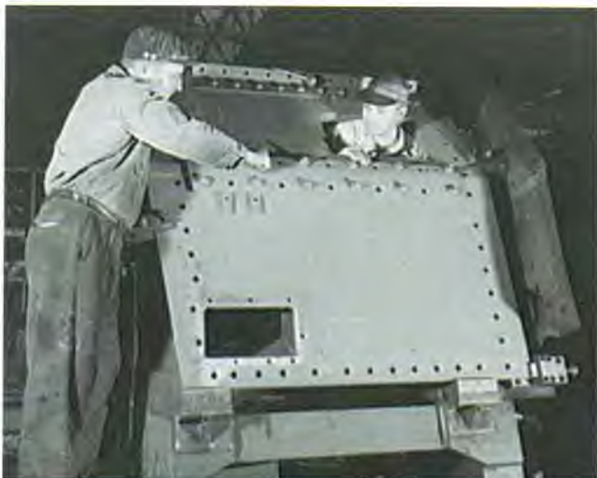
Il carro armato medio statunitense M3, noto come Lee (Grant per i britannici) entrò in servizio nell'estate del 1941. Aveva la corazzatura dello scafo interamente costituita da piastre di acciaio balistico fissate mediante bulloni e dadi. (Library of Congress, USA)
