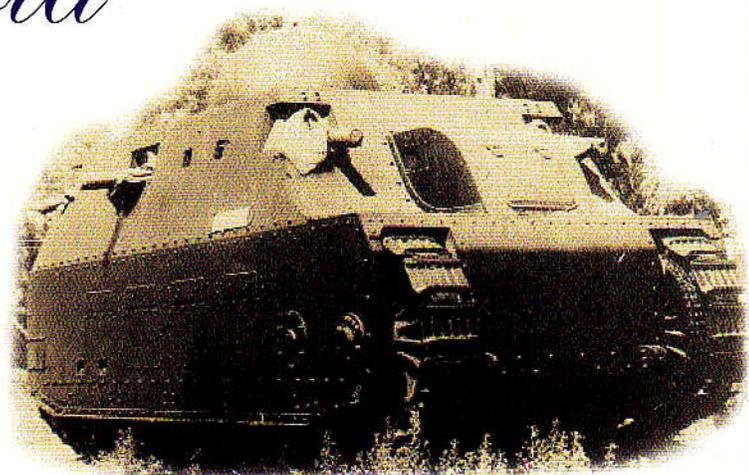
*(1917) - Fiat 2000, fu il primo carro armato progettato e costruito in Italia. Il posto di pilotaggio era sistemato in una protuberanza che permetteva al pilota una buona visibilità anche sui fianchi. Armamento: un obice da 65 mm in torretta girevole e 7 mitragliatrici da 6,5 mm. Peso t. 38.78.*
