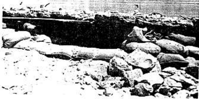
3/7/42 - cintura fortificata di Marsa Matruh - un fortino della difesa.
